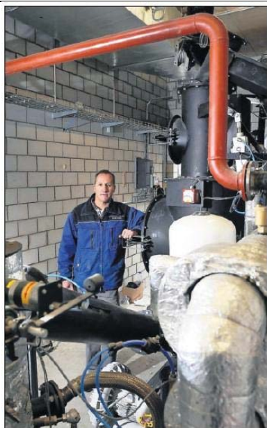
Urs Steinger, Betriebsleiter des Sägewerks Riedbrugg in Ettiswill, vor der Holzvergaseranlage. Bild: Boris Bürgisser
